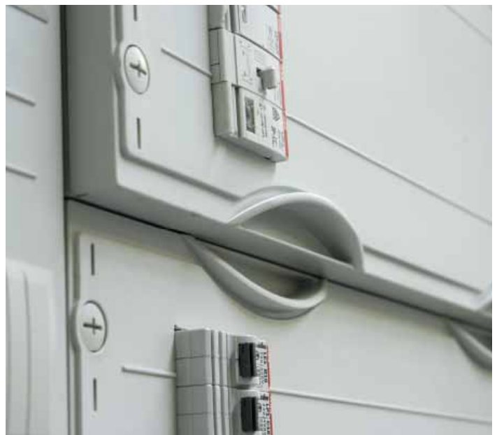
Вертикальное расположение оборудования
