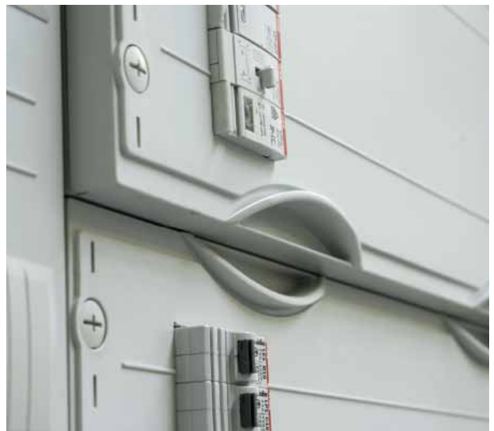
Вертикальное расположение оборудования
