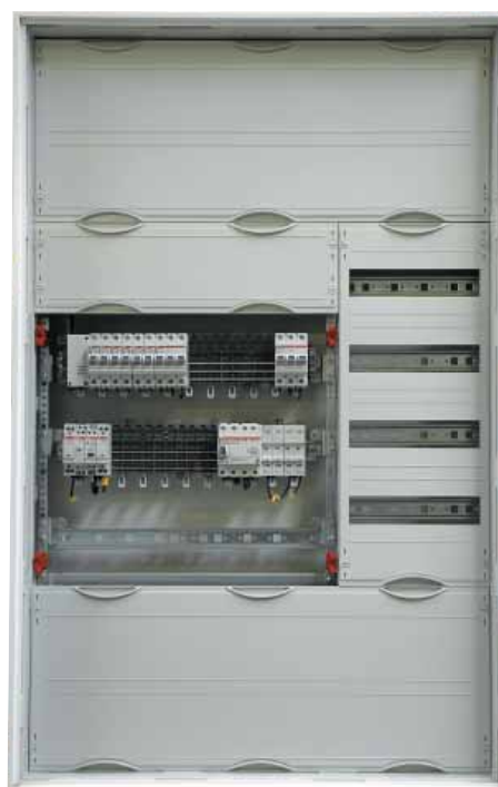
Настенный шкаф с модулями на монтажной раме EDF, включая модуль Combiline M для оборудования серии Smisline TP и модули Combiline для стандартных модульных устройств серии System proM.
