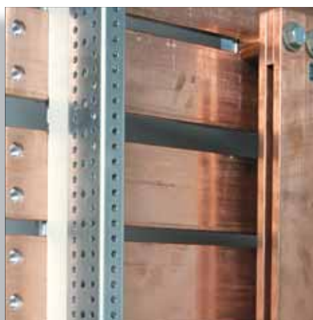
Расположение сборных шин повышает личную безопасность и помогает увеличить отвод тепла от шин
