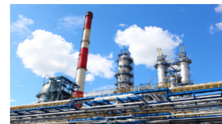
«ТАИФ-НК» Комплекс глубокой переработки тяжелых остатков
