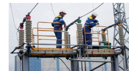
Реконструкция электрических сетей «Донэнерго»
