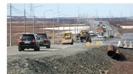
Обустройство автодороги Норильск-Оганер
