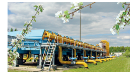
ООО «Газпром трансгаз Москва» «Тулское ЛПУМГ» Оснащение ИТСО и САЗ
