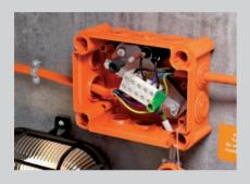
Кабельный ввод с кабельными резьбовыми вводами V-TEC.
