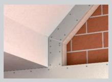
Гибкое расположение короба обеспечивается индивидуальными фасонными деталями.
