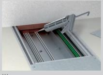
Швы и отверстия между проложенным кабелем и установленными пеноблоками необходимо закрыть огнестойкой шпатлевкой FBA-SP на глубину минимум 2 см.
