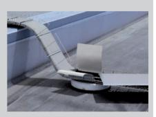
Использование при проведенных над противопожарной стеной линиях фотогальванических установок.
