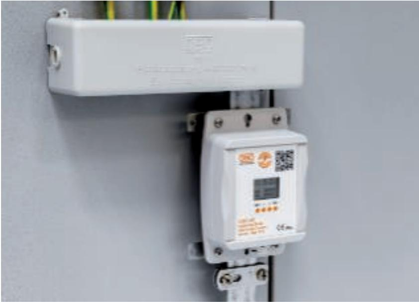
Счетчик тока молнии LSC I+II регистрирует токи молнии и импульсные токи (10/350, 8/20) и сохраняет события со временем и датой, протестировано в соответствии со стандартом VDE 0185-561-6 Ed.2. (IEC 62561-6 ред. 2)
