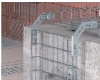
Готовый монтаж Установленный С-образный проволочный лоток.
