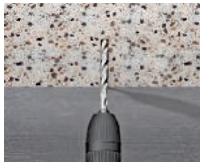
Просверлить дюбельное отверстие Просверлить в потолке отверстия соответствующего диаметра и глубины.
