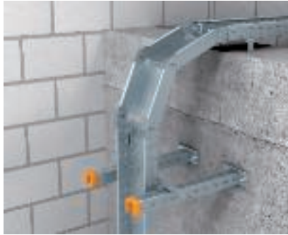
Монтаж нисходящего вертикального регулируемого угла Регулируемый угол вертикальный, нисходящий, для соединения участков трассы разной высоты. Регулируемый угол соединяется с кабельным лотком с помощью шарнирных соединителей.
