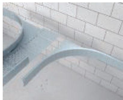
T-образное ответвление с помощью угловой секции Монтаж второго элемента угловой секции WEAS 110.
