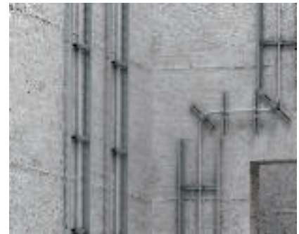
Вертикальная трасса Установленный вертикальный кабельный лоток лестничного типа.
