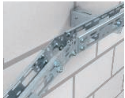
Вертикальное продольное соединение Вертикальное угловое соединение мини-каналов AZ с помощью 2-х соединителей VF AZK.
