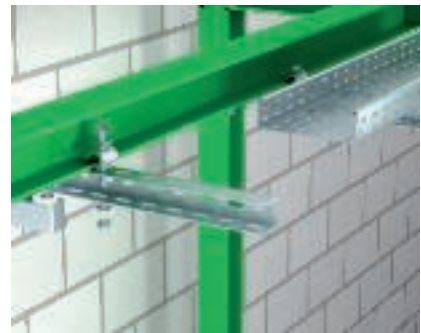
Монтаж кабельных лотков на стальных балках Монтаж кабельных лотков на стальных балках с помощью фиксаторов TKS-L-25 и U-образных стоек. Для придания прочности конструкции необходимо установить распорки DSK.
