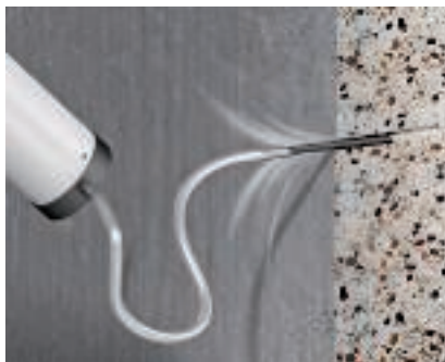
Продувка отверстия Удалить пыль из отверстия.
