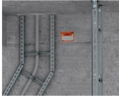
Изменение направления прокладки Изменение направления прокладки усиленных вертикальных кабельных лотков лестничного типа SLM.
