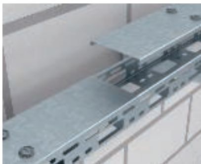
Крепление крышки Монтаж крышки AZDMD мини-канала AZ.
