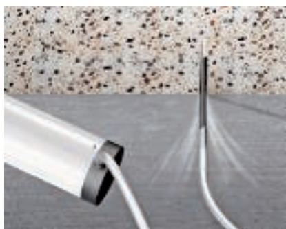
Продувка отверстия Удалить пыль из отверстия.
