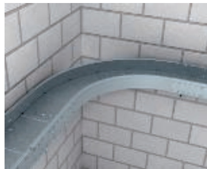
Монтаж угловой секции 90° Угловая секция в комбинации с кабельным лотком для больших расстояний. Угловая секция крепится к кабельному лотку с помощью внешних соединителей и стыковой планки.
