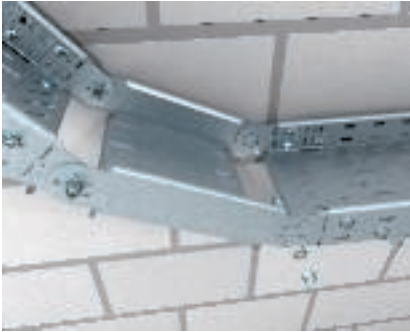
Монтаж вертикального регулируемого угла Монтаж вертикального регулируемого угла для создания угловой секции кабельной трассы. Вертикальный регулируемый угол необходимо соединить с кабельным лотком с помощью шарнирных соединителей.
