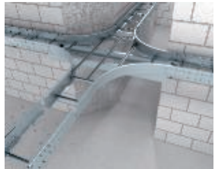
Монтаж крестообразной секции Крестообразная секция в комбинации с кабельным лотком лестничного типа для больших расстояний. Крестообразная секция крепится к кабельному лотку лестничного типа с помощью внешних соединителей.
