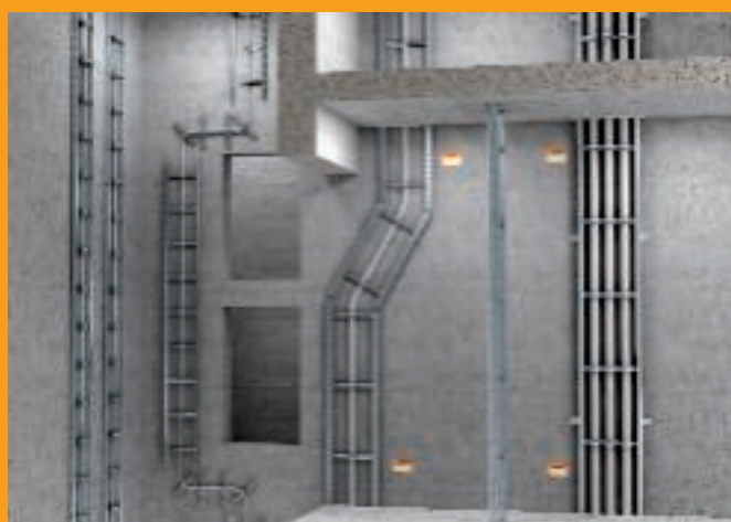
Вертикальные кабельные лотки лестничного типа
