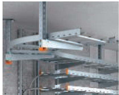
Готовый монтаж Установленный кабельный лоток лестничного типа.
