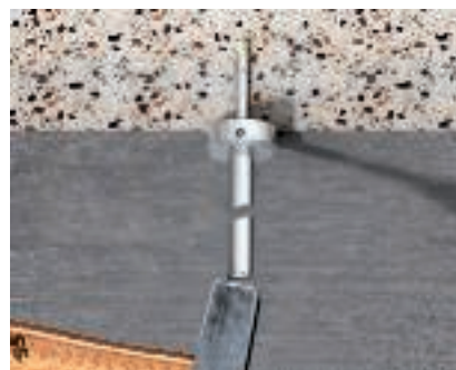
Установка распорного дюбеля BZ IG Вбить распорный дюбель тип BZ-IG соответствующим инструментом. Затем прикрепить скобу.
