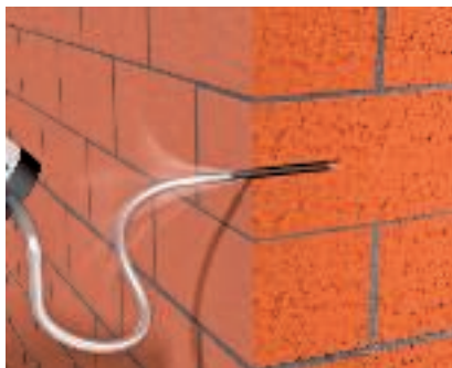
Продувка отверстия Удалить из отверстия пыль путем продувания.
