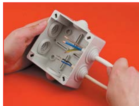
3 этап. Ввод кабеля
