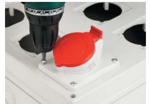
Монтаж розетки на 32 А
