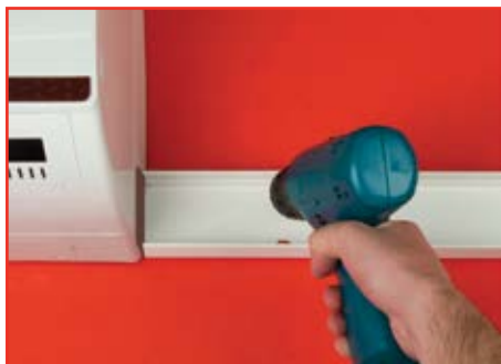
Закрепите основание короба на стене
