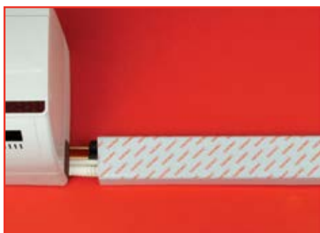
Закройте смонтированную трассу крышкой
