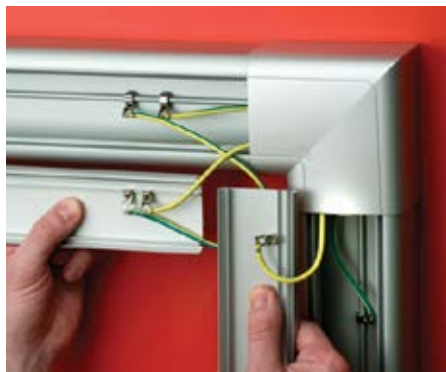
Количество монтируемых проводов заземления в плоском угле
