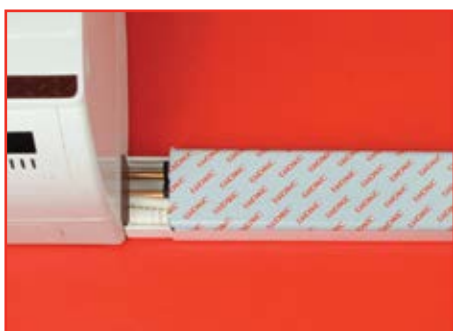
Закройте смонтированную трассу крышкой
