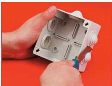
1 этап. Срезаем кабельный ввод
