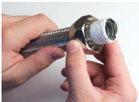
1. Вначале следует надеть на металлорукав зажимную гайку
