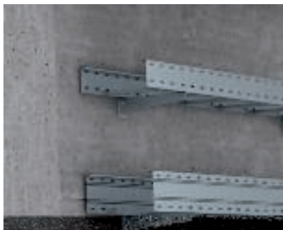
Применение при настенном монтаже Прямой настенный монтаж систем кабельных лотков для больших расстояний.
