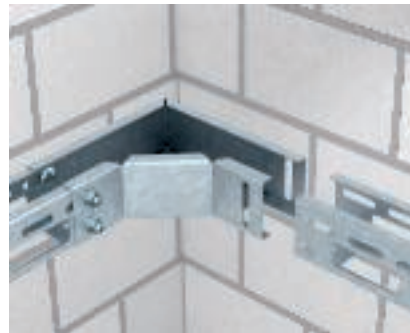
Установка фасонной детали кабельного лотка для монтажа светильников Монтаж фасонных деталей кабельных лотков для монтажа светильников.
