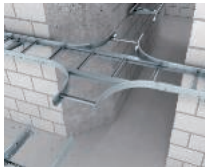
Создание крестообразной секции Монтаж двух секций тип LAA для создания крестообразной секции.
