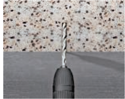
Просверлить дюбельное отверстие Просверлить в потолке отверстия соответствующего диаметра и глубины.
