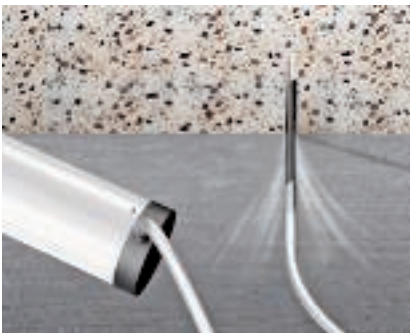
Продувка отверстия Удалить пыль из отверстия.
