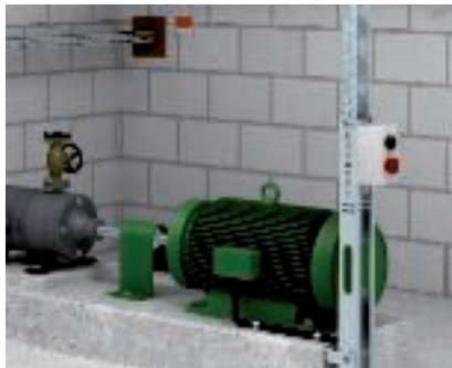
Стойка подвода питания к электрооборудованию Соединение электроприводов со стойкой для подвода питания.
