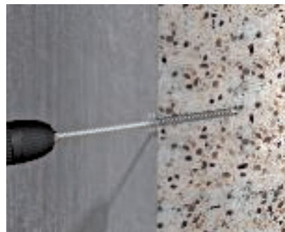
Очистка стальной щеткой Очистить отверстие стальной щеткой. Процесс чистки продуванием и механической чистки стальной щеткой необходимо провести 2 раза.
