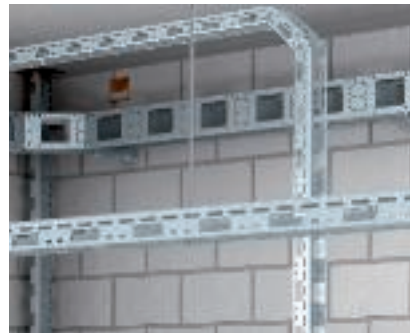
Мини-канал AZ Подвесной монтаж мини-канала AZ с помощью стержня с резьбой, а также переход из горизонтальной плоскости прокладки в вертикальную.
