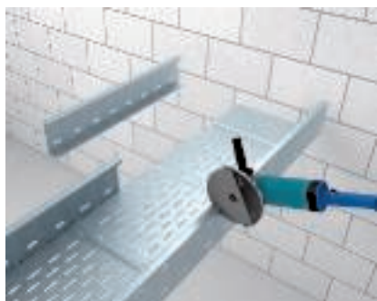
T-образное ответвление с помощью угловой секции Извлечение боковых стенок кабельного лотка для больших расстояний.
