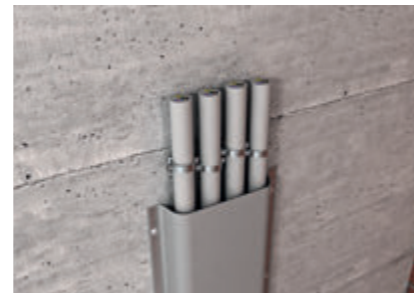
Крепление бандаж с помощью металлических реек при монтаже с дистанционными скобами.
