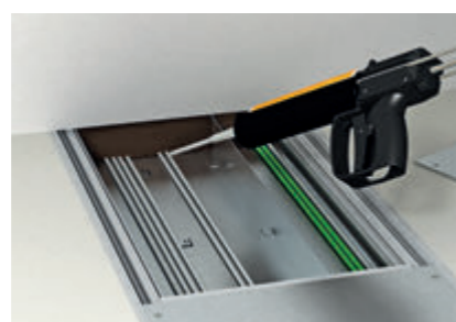
Нанесение огнестойкой пены непосредственно под стену.
