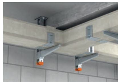
Предварительно смонтированные стандартные фасонные детали в трассах.
