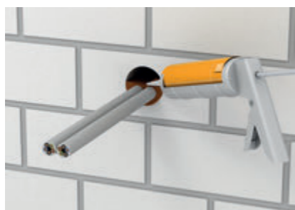
Заполнение отверстия шпатлевкой FBA-SP.
