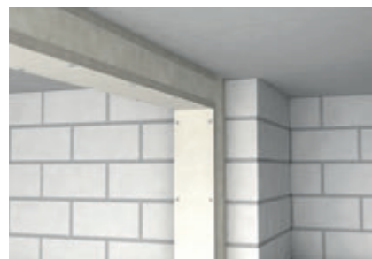
Прямой настенный и потолочный монтаж.
