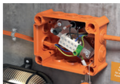
Ввод кабеля с помощью уплотнителей.
