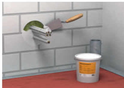
Заделка поверхностей огнестойким покрытием DSX с обеих сторон (минимальная толщина 1 см).
