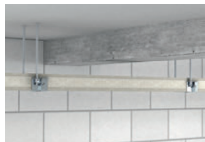
Подвесной монтаж на соединительных элементах.
