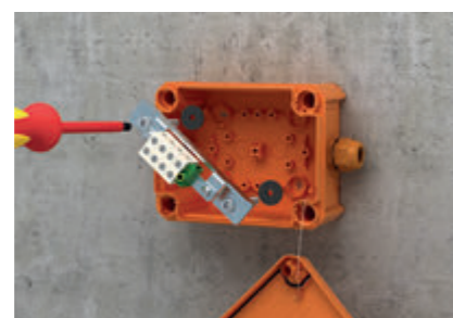
Настенный монтаж огнестойкой распределительной коробки FireBox.
