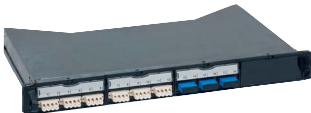
335 10 с установленными блоками оптических соединителей
