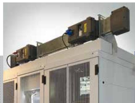
**2** Установка отводных блоков
