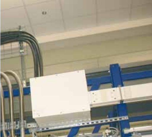
Canalis KS и sprinkler.
